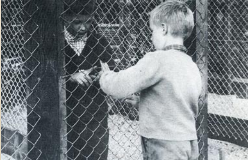
1962 – „Kleine' Hilfe bei Bau des neuen Tierheims
