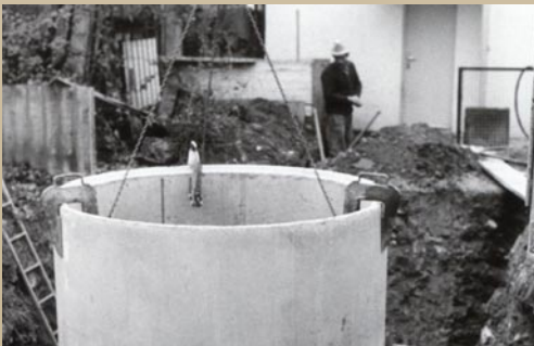
1993 – Einbau Abwasserschacht im Tierheim
